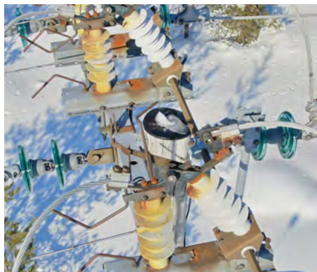
Dronella voidaan mm. erotimien viat tutkia ilman asiakkaille aiheuttavaa sähkökatkosta.
