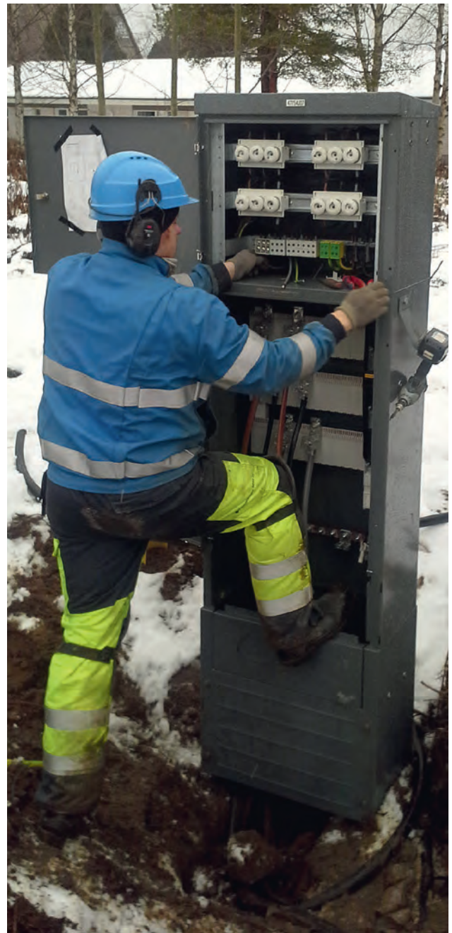
Liittymäjakaapin kytkentä
