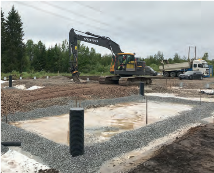
Liakan sähköseman rakentaminen
