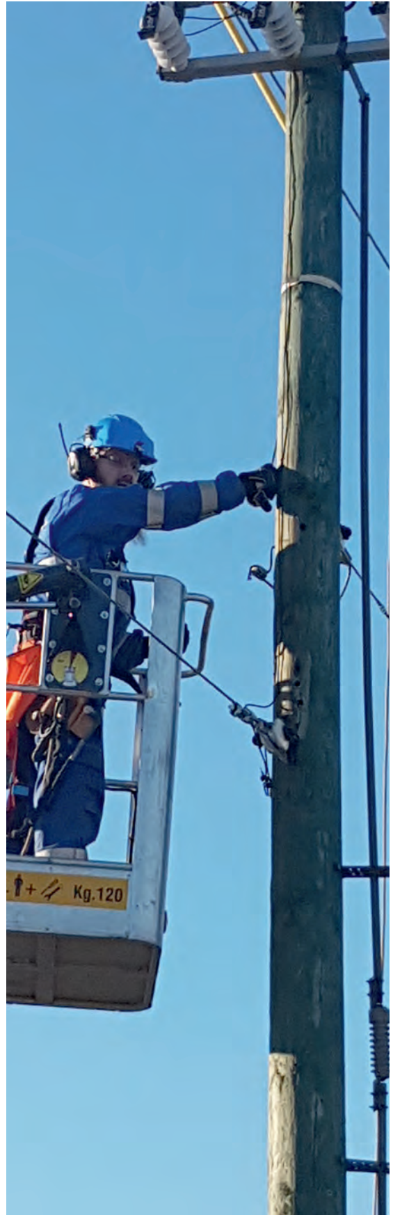
Erottimen asennus
