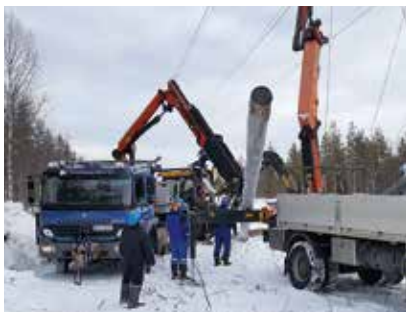
◀ Pylvään vaihto 110 kV -linjalla.
