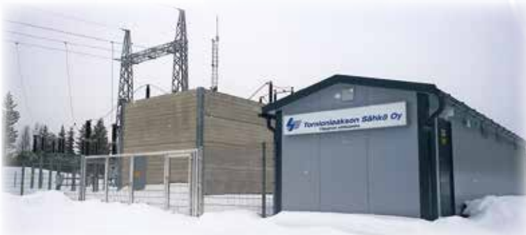
Ylläsjärvelle rakennettiin uusi sähköasema.
